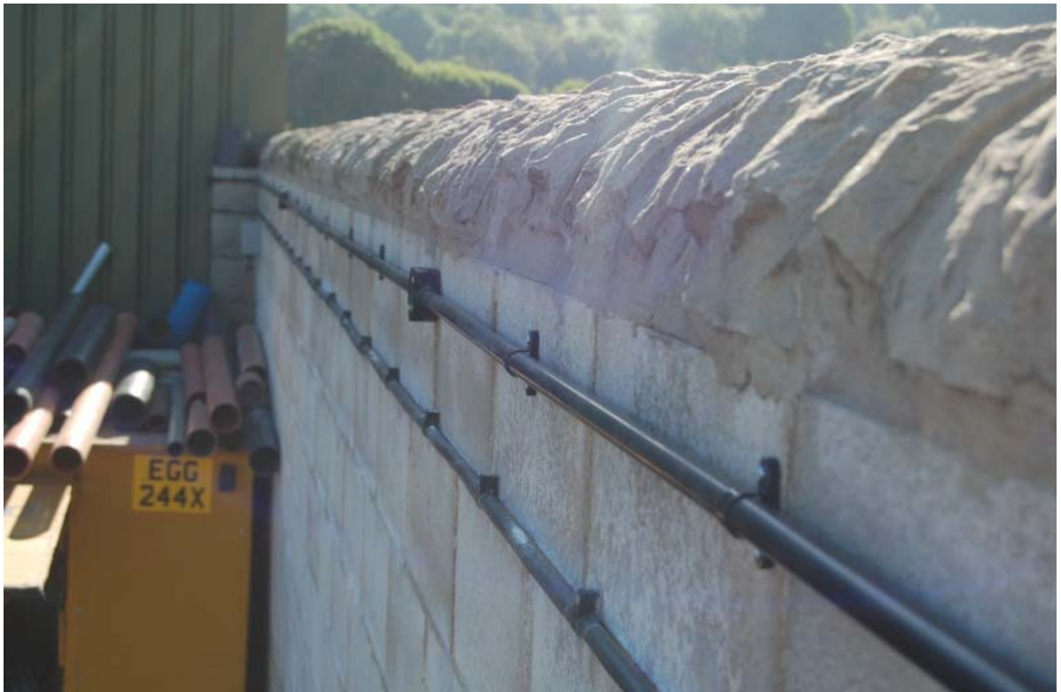
Рис.4 Инсталляция системы VibraFon на стене.
