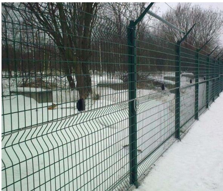
Размещение датчиков и прокладка соединительного кабеля на ограждении
